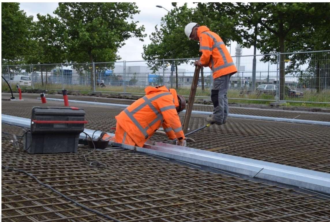
Foto: Aanleg wapening voorziening.
