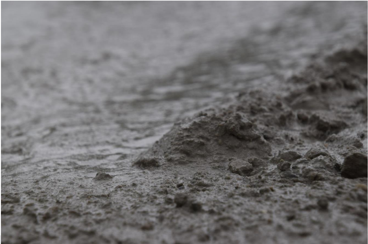
Foto: Detail betonmortel.
